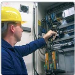
Quasiment tout appareil consommateur électrique devient chaud lorsqu'une anomalie se développe. C'est pourquoi la surveillance thermique à l'aide d'un thermomètre optris LS LT est un point essentiel de la maintenance préventive.
